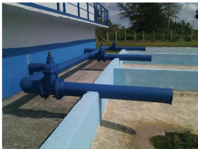
Figura 11.- Conductos del tanque Imhoff hacia el lecho de secado (A y B) (Figura extraída del documento original).
