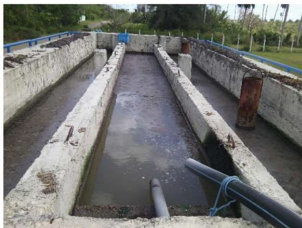
Figura 9.- Tanque Imhoff y vista superior (A y B) (Figura extraída del documento original).
