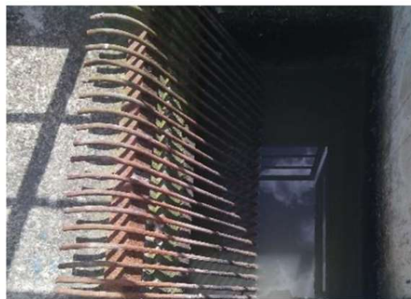
Figura 8.- Cámara de rejillas y vista superior (A y B) (Figura extraída del documento original).
