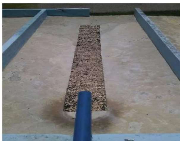
Figura 11.- Conductos del tanque Imhoff hacia el lecho de secado (A y B) (Figura extraída del documento original).
