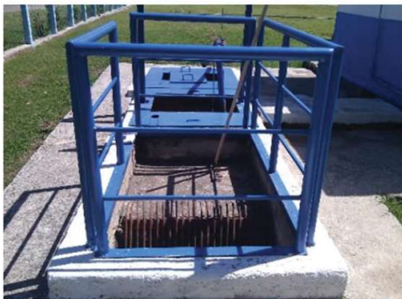
Figura 8.- Cámara de rejillas y vista superior (A y B) (Figura extraída del documento original).
